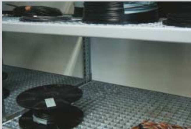
R 3000: zárt polclap helyett acél tárolórács. Tűzmelegelőzésre szórófejes tűzoltóberendezést alkalmazunk.
