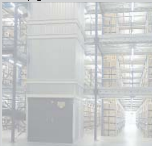
Raktári galériák és állványra épített járófelületek
